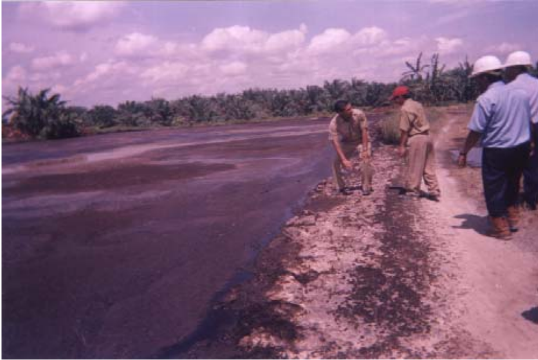
Gambar 2.3. Kondisi Kolam IPAL Salah Satu Perusahaan di Kabupaten Kuantan Singingi Tidak Sesuai Dengan Standar.
