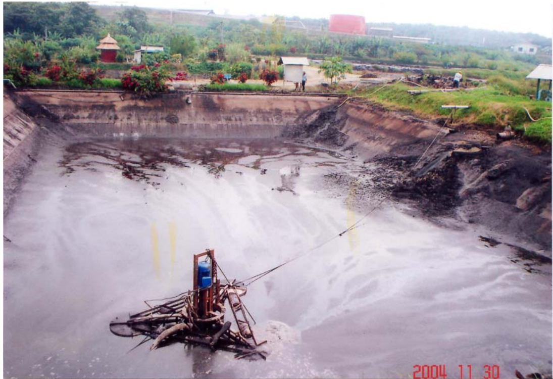
Gambar 3.4. Kondisi Kolam IPAL Salah Satu Perusahaan Di Kabupaten Kuantan Singingi Yang Tidak Sesuai Dengan Standar.
