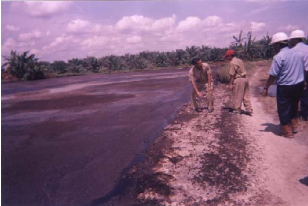
Gambar 2.3. Kondisi Kolam IPAL Salah Satu Perusahaan di Kabupaten Kuantan Singingi Tidak Sesuai Dengan Standar.
